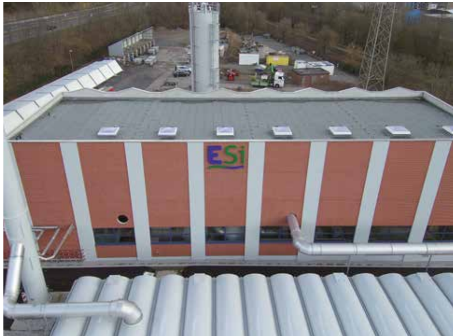
Neue Maschinenhalle für die Klärschlamm-trocknung des ESi in Siegen
